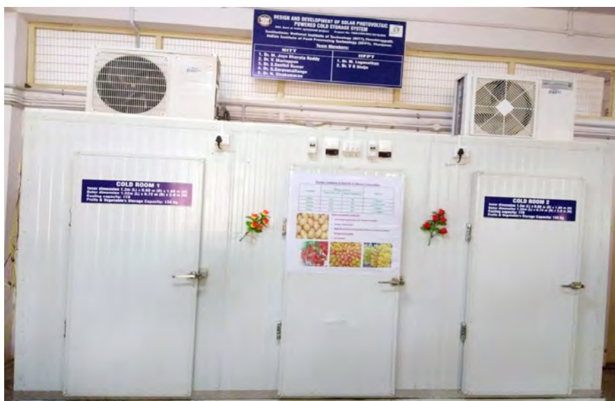
चित्र 2. निर्माणित प्रोटोटाइप सौर कोल्ड स्टोरेज (पीएससीएस) प्रणाली
